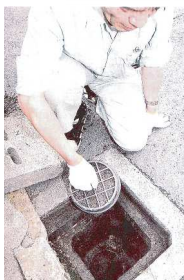
排水溝に取り付けられた円筒形の浸透升。土をせき止めるフィルターを上からかぶせる＝姫路市吉田町
